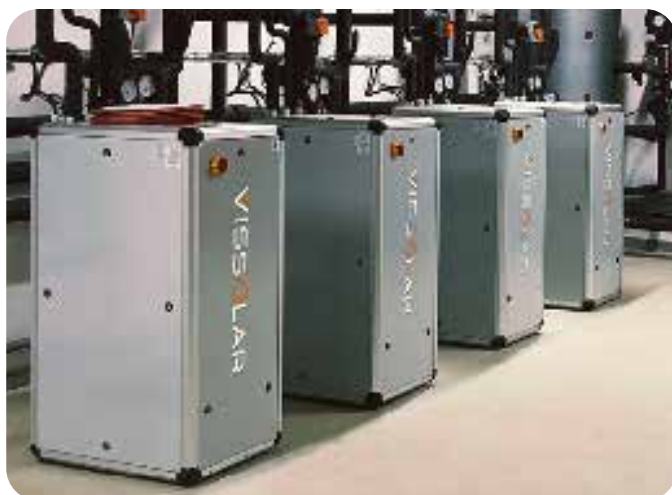
4x AC60IS VISSOLAR air climate system in Kaskaden-Schaltung (Gebäude-Wärmebedarf 200.000 kWh)
